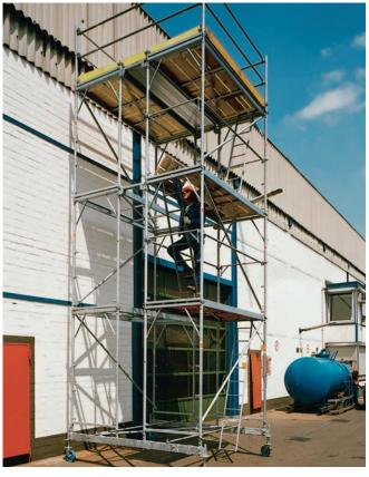
Mit nur wenigen Zusatzteilen erschließen Sie sich auch hier ein neues Einsatzgebiet. Ein Fahrgerüst, das in geschlossenen Räumen eine Standhöhe von 10,50 m und im Freien von 8,50 m erlaubt.
