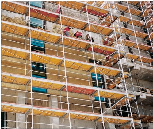
Gemäß der aktuellen DIN 4420 werden Gerüste nach ihrer Leistungsfähigkeit in Bezug auf die Maximalbelastung in sechs verschiedene Gerüstgruppen eingeteilt. Durch die Auswahl des Belages bestimmen Sie selbst die maximal mögliche Belastung von BOSTA 100 und damit die Zugehörigkeit in den definierten Gerüstgruppen.
