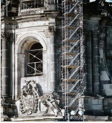
Auch für die Auf- und Abstiege gilt, was beim gesamten BOSTA 100 System im Vordergrund steht: aus wenigen Teilen lassen sich komfortable Lösungen bauen.
