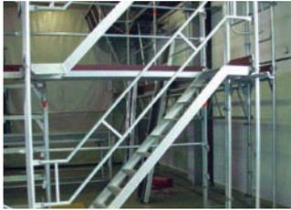
Bequemer Gerüstaufstieg und Materialtransport mit Alu-Treppen und Geländern. Als Fußpunkt für die unterste Treppe bildet der U-Anfangsriegel eine sichere Auflagerung.\*
